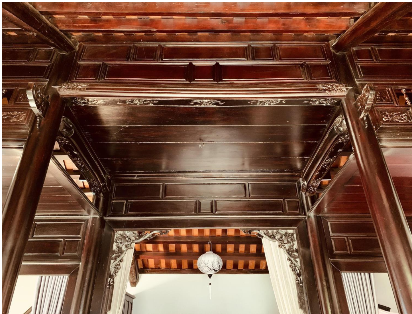
Cách lợp ngói liệt bảo tồn trong các công trình nhà rường
